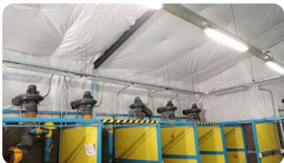
Mantenimiento cubierta y forros de Talleres de Liceo Bicentenario de Excelencia Industrial de Tomé.
