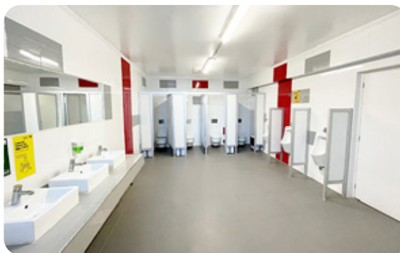
Conservación de servicios higiénicos y camarines de Liceo Bicentenario de Excelencia Comercial Insuco.
