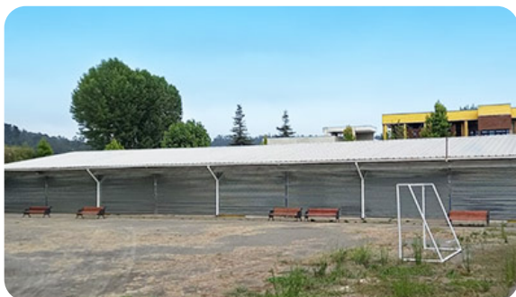
Cortinas metálicas sector Talleres de Liceo Industrial de Concepción.
