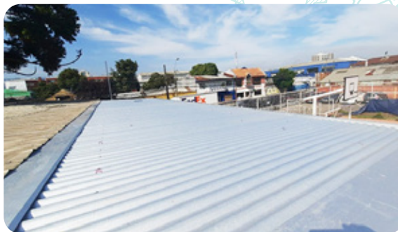
Reposición techumbre de sector inspección de Liceo Comercial Femenino de Concepción.
